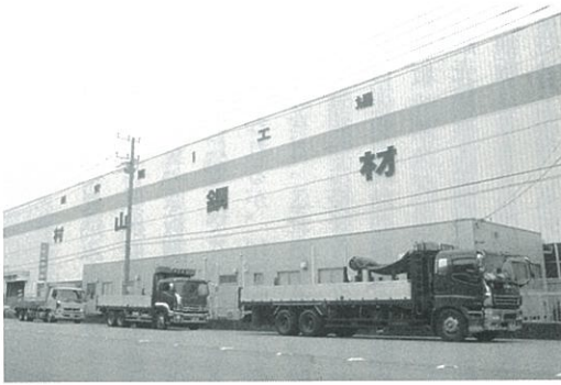
浦安第一工場の外観
